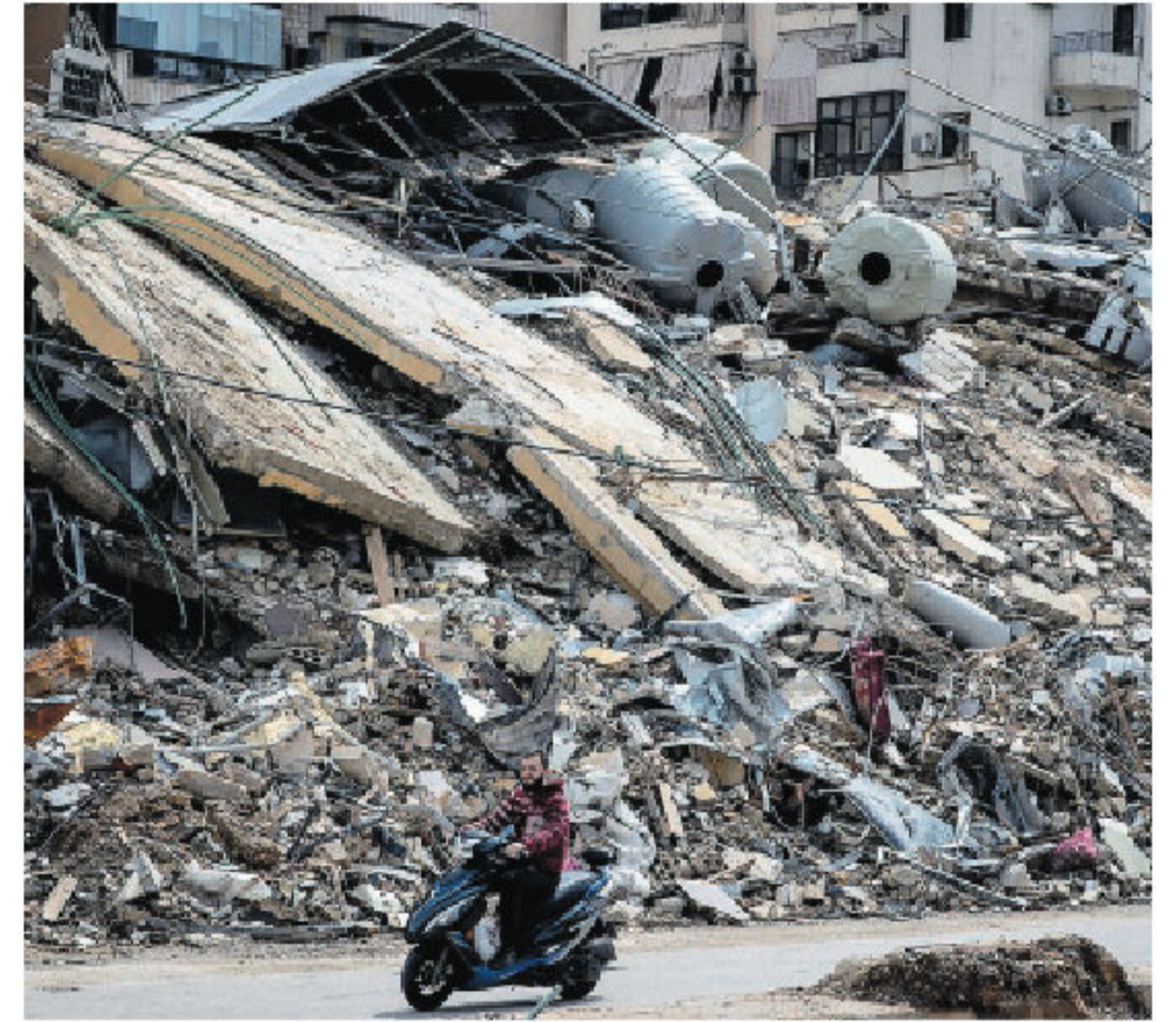
Edificios destruidos en Beirut, ayer. CHRIS MCGRATH (GETTY)
